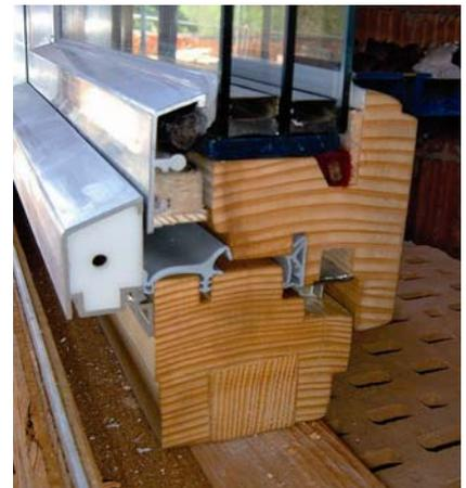
Hochgedämmtes Fenster mit Dreifachverglasung
