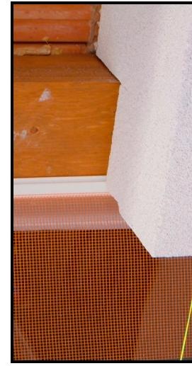
Fig. 27: Wärmedämmung vor Blindstock/
