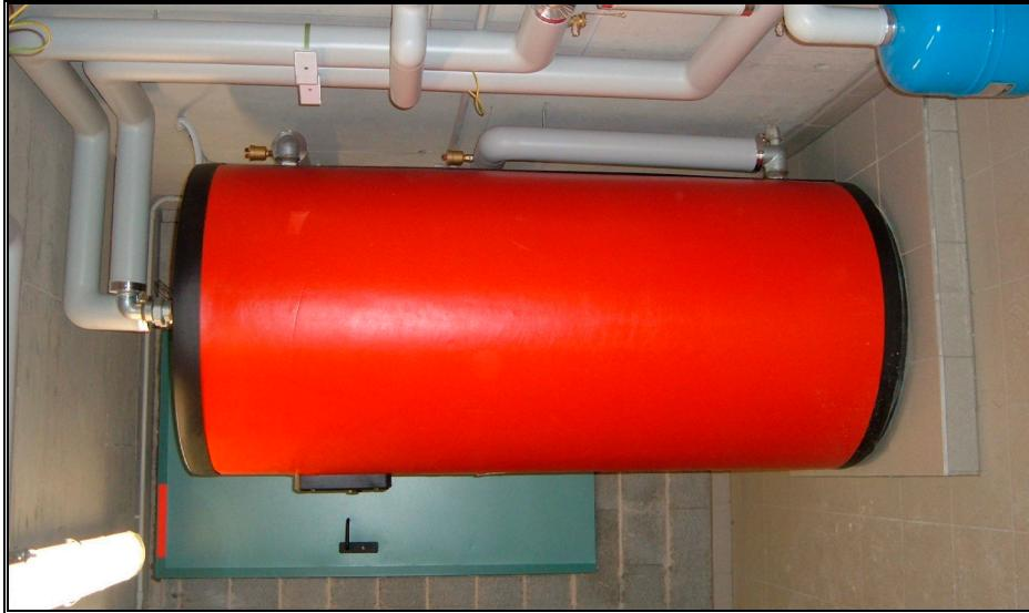
Fig. 39: Warmwasserspeicher /
