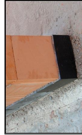
Fig. 28: Mauersohle auf Schaumglasblock aufgesetzt/
