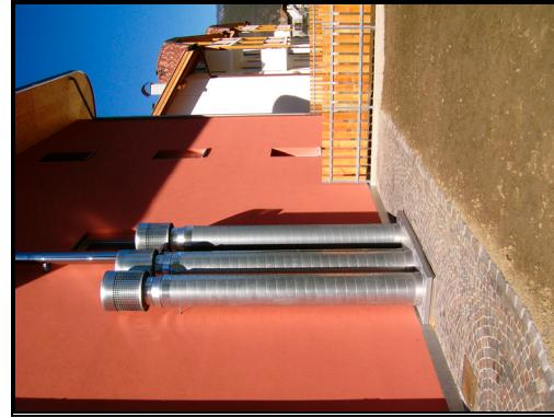
**Fig. 33: Ansaugung der Frischluft und Auslass der Abluft/
