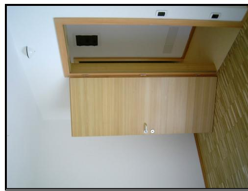
**Fig. 32: Frischluftdüse oberhalb der Tür/
