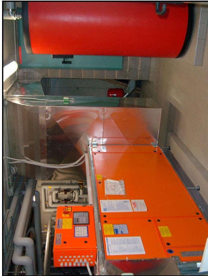
Fig. 31: Zentrale Lüftungsanlage im Technikraum/
