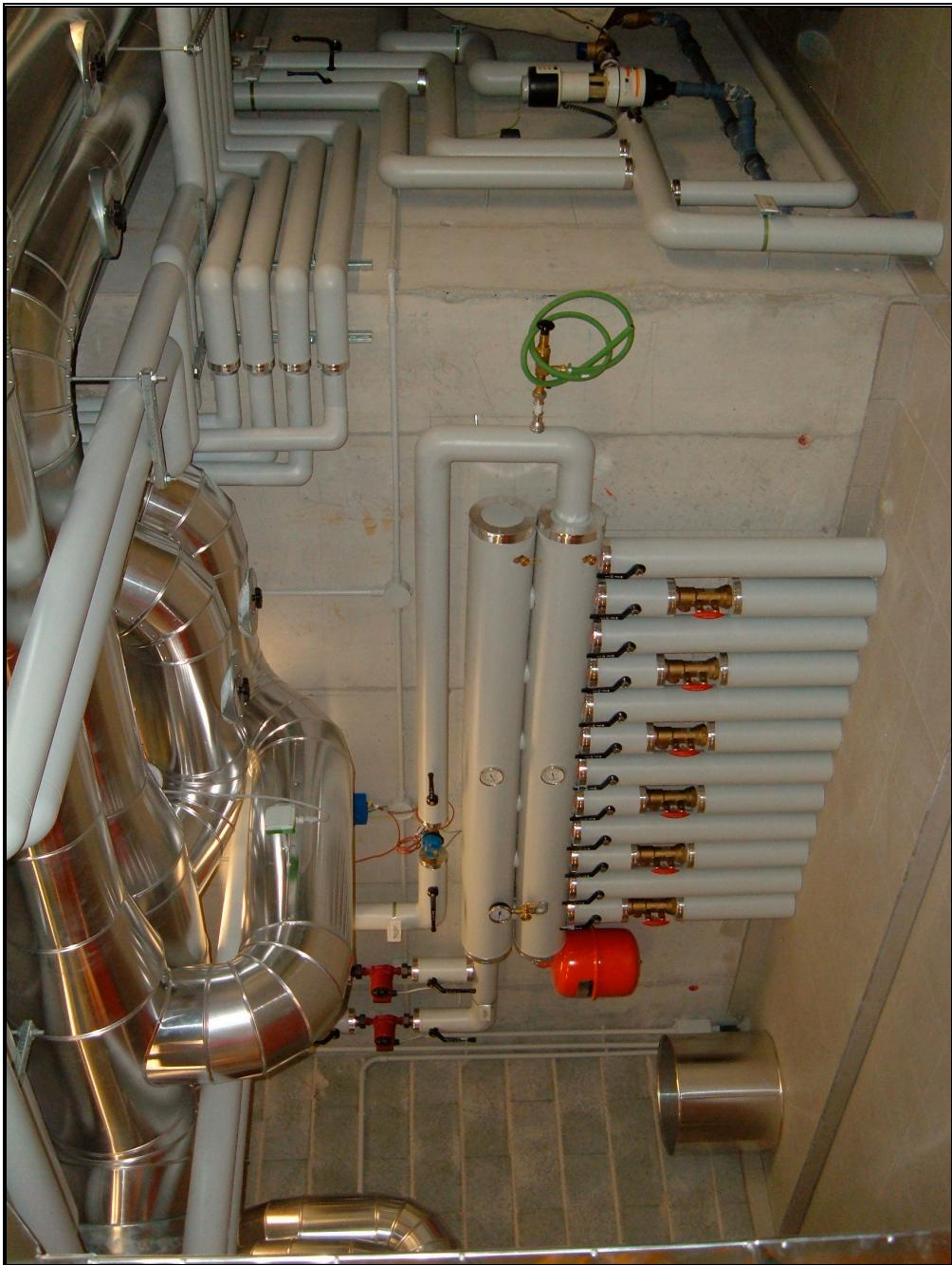
Fig. 35: Sammellohr der geothermischen Anlage und Lüftungskanäle im Technikraum/
